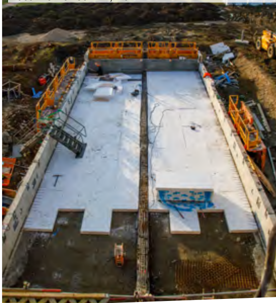
Centre Aquatique Communautaire de Basse-Ham Bassin extérieur - 11/2021
