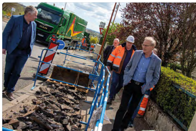
► 14.04.2023 : visite de chantier assainissement à Illange
